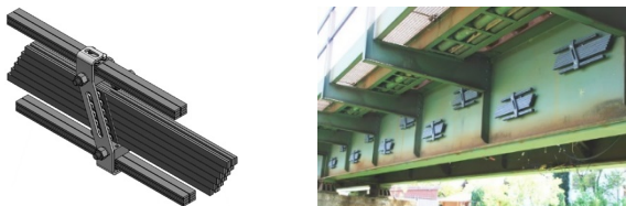
Abbildung 1: Modell eines Brückendämpfers (l.) und montierte Brückendämpfer an Längsträger-Stegblechen einer Eisenbahn-Stahlbrücke (r.). © Schrey & Veit GmbH
